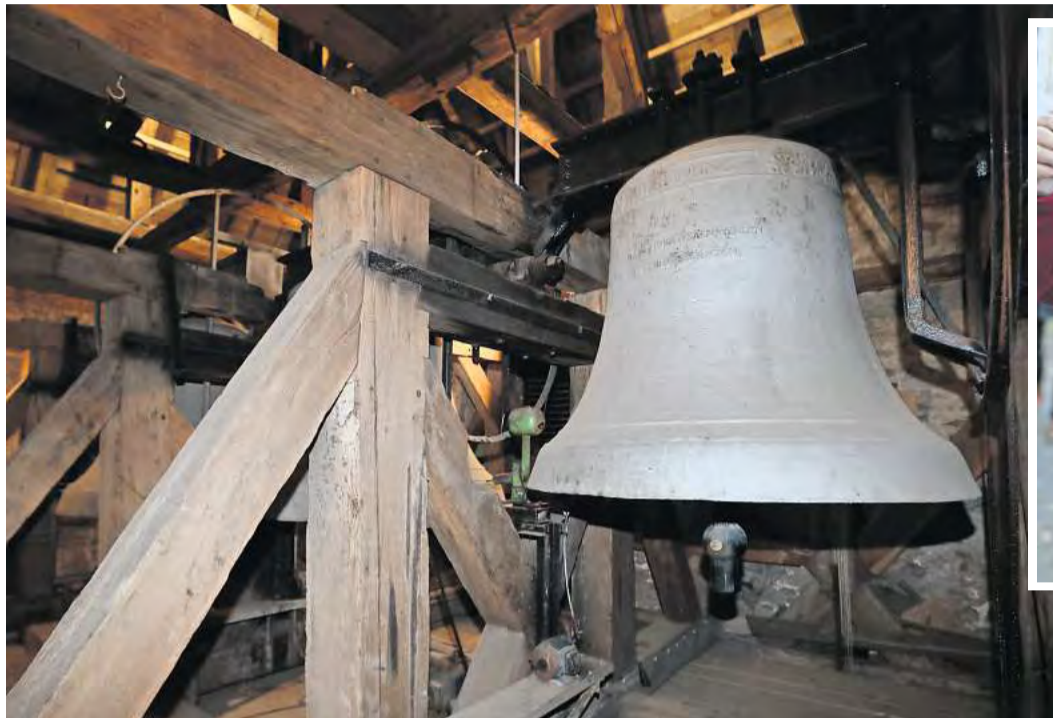
Glockenstuhl in der St. Petrus-Kirche: Sowohl dieses dreistimmige Geläut als auch die Glocken in der Vorsfelder St.-Michael-Kirche sollen durch neue aus Bronze ersetzt werden. FOTOS (2): BRITTA SCHULZE
